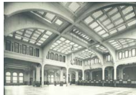
Vue du grand hall et des guichets L'ossature en béton armé libère l'espace sur des portées inédites
