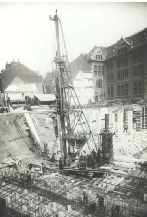
Travaux des fondations du beffroi
