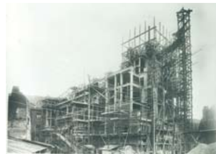
Vue de l'ossature en béton armé Le jeu des poutres et des poteaux décide de l'écriture architecturale
