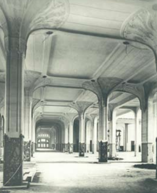
Les colonnes de la grande galerie en voie d'achèvement
