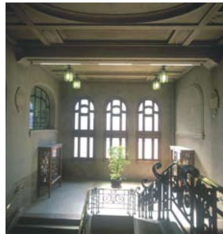
L'un des deux escaliers d'honneur de part et d'autre de la grande galerie Balustrades en fer forgé, plafond en béton moulé et luminaires au verre dépoli
