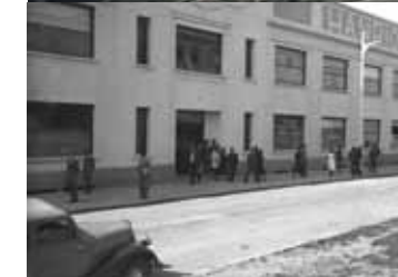
Sortie du personnel du bâtiment de l'administration, rue Le Brix, vers 1937 (AD Cher - Fonds MBDA France - Fonds 117)).
