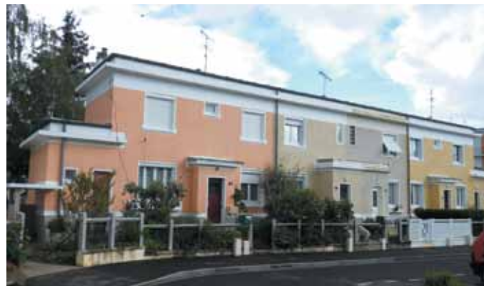
Les mêmes après travaux, 2013 (service patrimoine).
