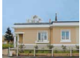
Pavillon de type C, rue Latham (service patrimoine).
