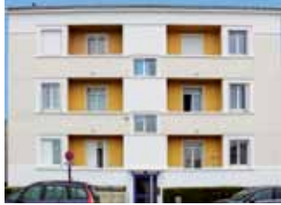
Immeuble 1, rue Le Brix (service patrimoine).
