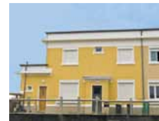
Pavillon de type B', rue Mesmin (service patrimoine).
