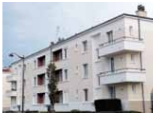
Immeuble 2, rue Le Brix (service patrimoine).
